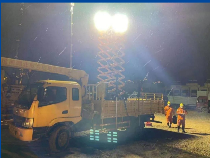
新冠疫情期间，海洋王人克服困难，及时响应客户需求；勇于请战，保障各地“小汤山”医院建设施工照明；坚守岗位，支援客户临时防控点的照明需求；关心客户，想尽办法为客户解决防疫物资短缺问题……（图为武汉网电服务中心为火神山医院施工现场保障照明）
